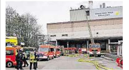
Der Brand im Müllheizkraftwerk löste einen Großinsatz der Feuerwehr aus.
